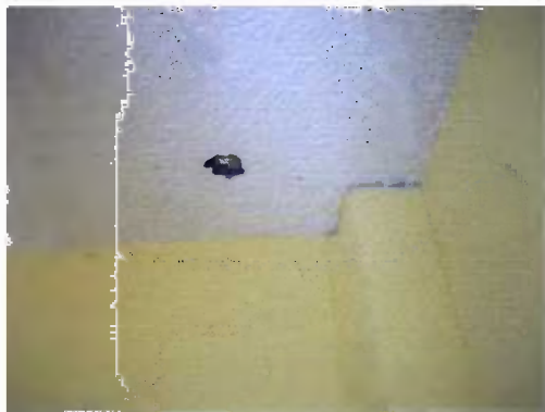
Fotografía N° 17. Vista del Cielo del Baño.
