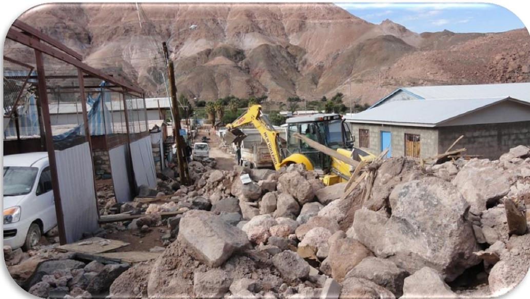
**OBRAS DE LIMPIEZA Y RETIRO DE ESCOMBROS VOLUMINOSOS POR DAÑOS OCASIONADOS POR INVIERNO ALTIPLANICO**
